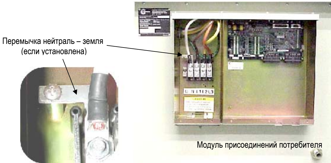
Рисунок 75 Перемычка нейтраль-земля в модуле присоединений потребителя
