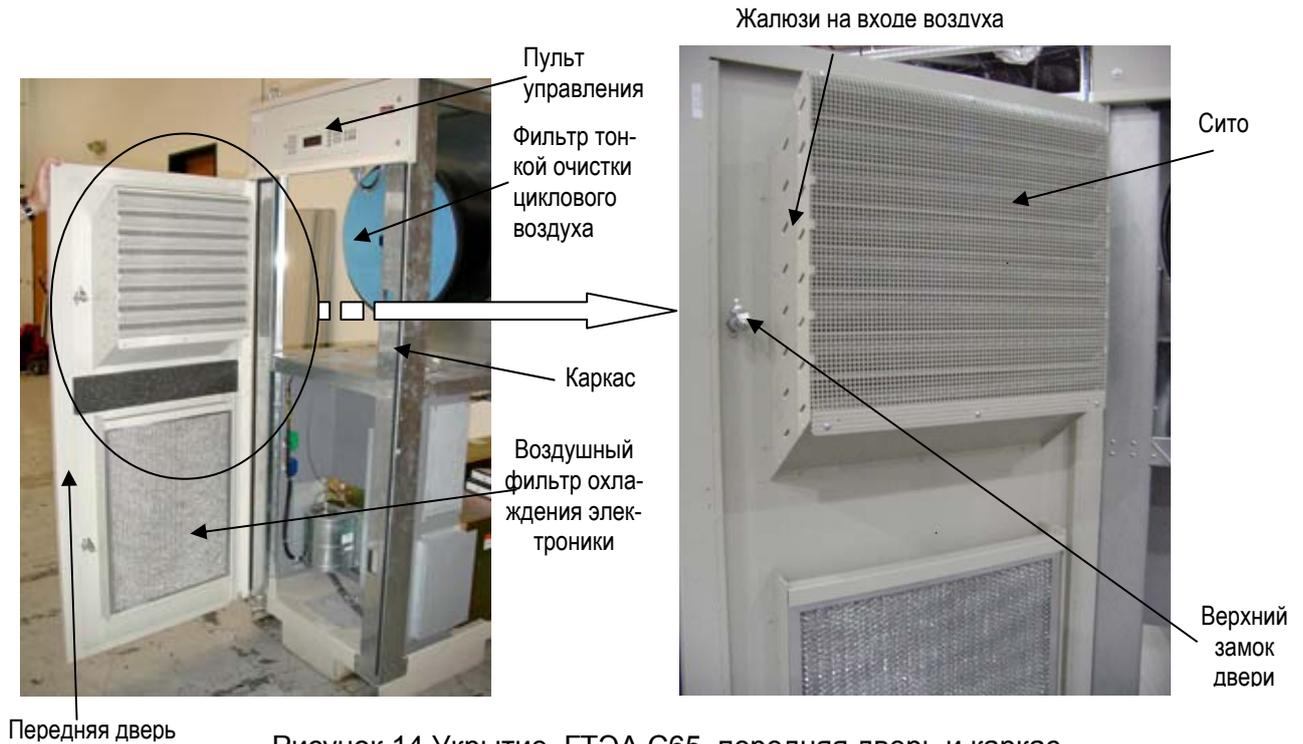
В нижней части каркаса имеются полости, служащие для транспортировки ГТЭА погрузчиком. В потолочной панели (крыше) имеется отверстие для вывода выхлопного газохода. На задней панели укрытия размещён модуль присоединений потребителя (рис.12) для присоединения силовых линий, линий управления и коммуникации. В нижней части задней панели через отверстие выведен штуцер для подключения топливного трубопровода. Габаритные и присоединительные размеры ГТЭА указаны в приложениях 1 и 2.
