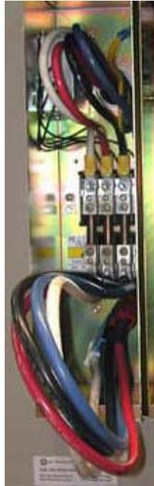
Рисунок 55 Клеммы присоединения потребителей переменного тока
