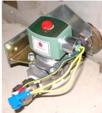
Рисунок 20 Отключающий клапан
