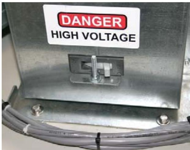
Рисунок 98 выключатель блока АКБ
