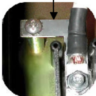
C60 Клемма и винт Нейтраль-Земля
