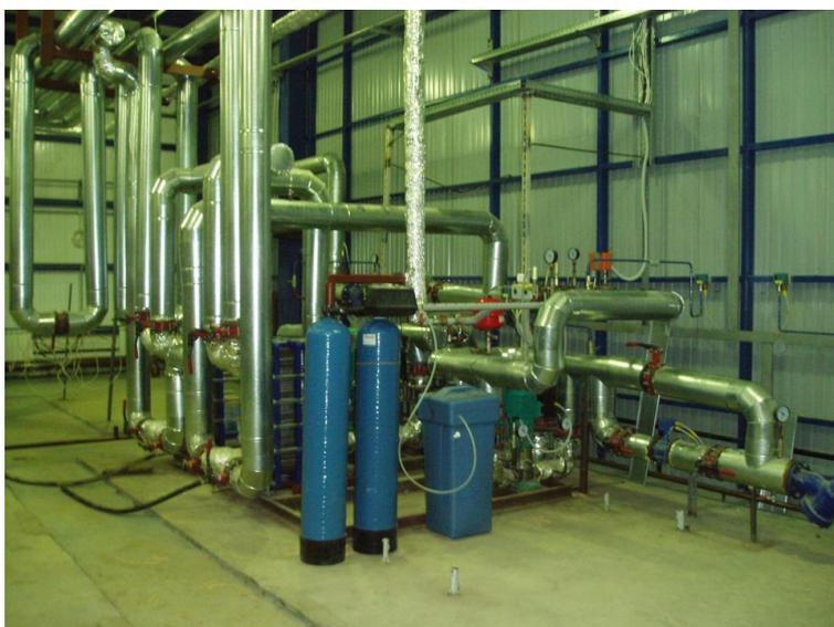
Рис.3. Система горячего водоснабжения для потребителей
