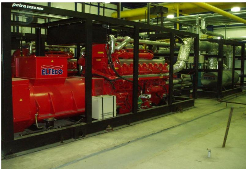
Рис.2. Газопоршневая когенераторная установка
